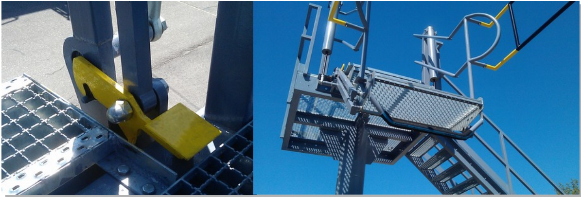
9. ábra: a. Rögzítőkarom és pedál, b. Gumiborítású támasztókengyel
