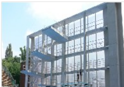
Hajós Alfréd Uszoda Műugró torony korlátrendszere
